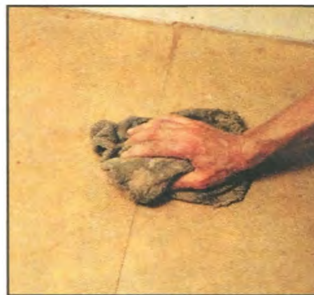
Основу из ДСП тщательно зачищают. Следы шпательки на стыках удаляют шлифованием.
