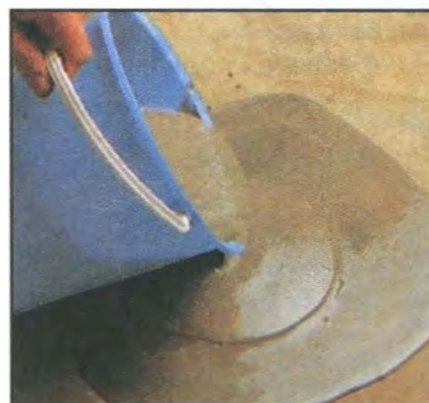
Наиболее простой способ выровнять бетонное основание — залить стяжку из самовыравнивающейся смеси.
