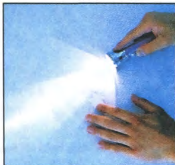
Луч света помогает найти на стене малозаметные неровности.
