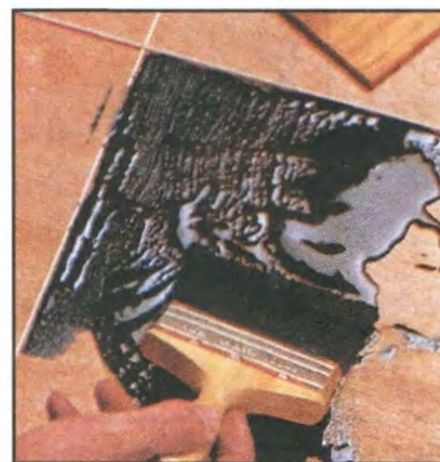
Клей для укладки первого паркетного элемента наносят у точки пересечения шнуров в середине помещения.
