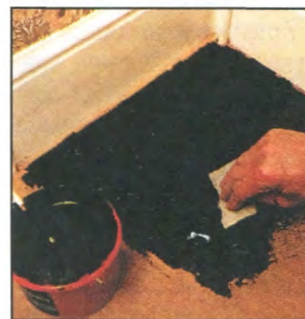
Клей надо наносить на участок пола, предназначенный для укладки только одного паркетного элемента.
