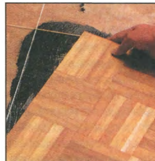
Укладка первого паркетного элемента. Паркет следует класть аккуратно, чтобы клей не попал на его поверхность.
